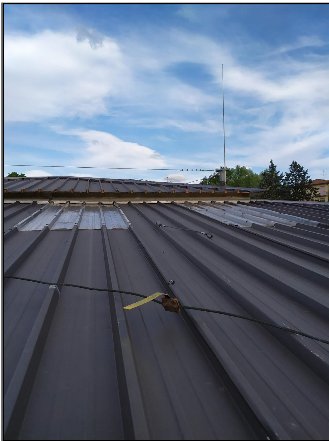
Figura 5 – particolare nuova copertura in lamierino coibentato
