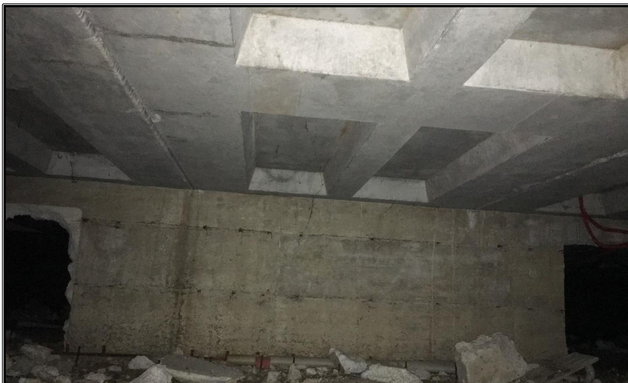
Figura 3 - vano interrato con solaio nervato di calpestio visto dal basso e parte in elevazione delle fondazioni in ca
