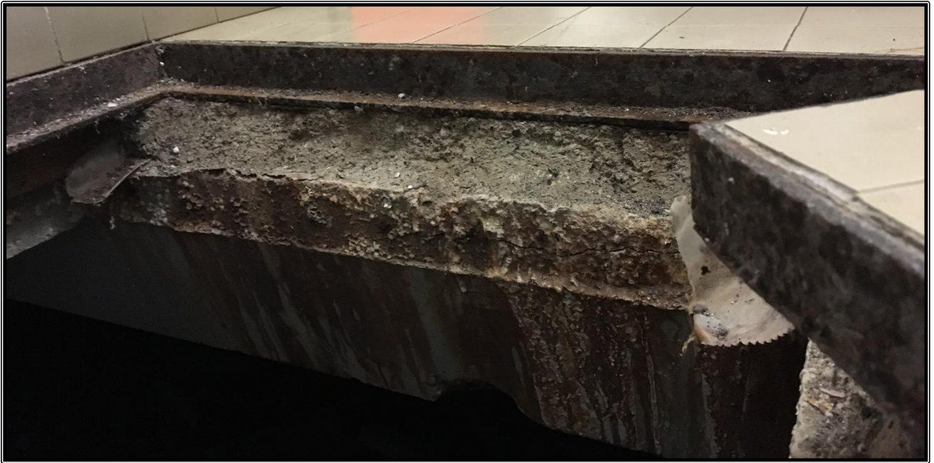
Figura 4 - stratigrafia solaio di calpestio (24cm lastre prefabbricate + 6cm soletta + 4cm caldana e pavimentazione)
