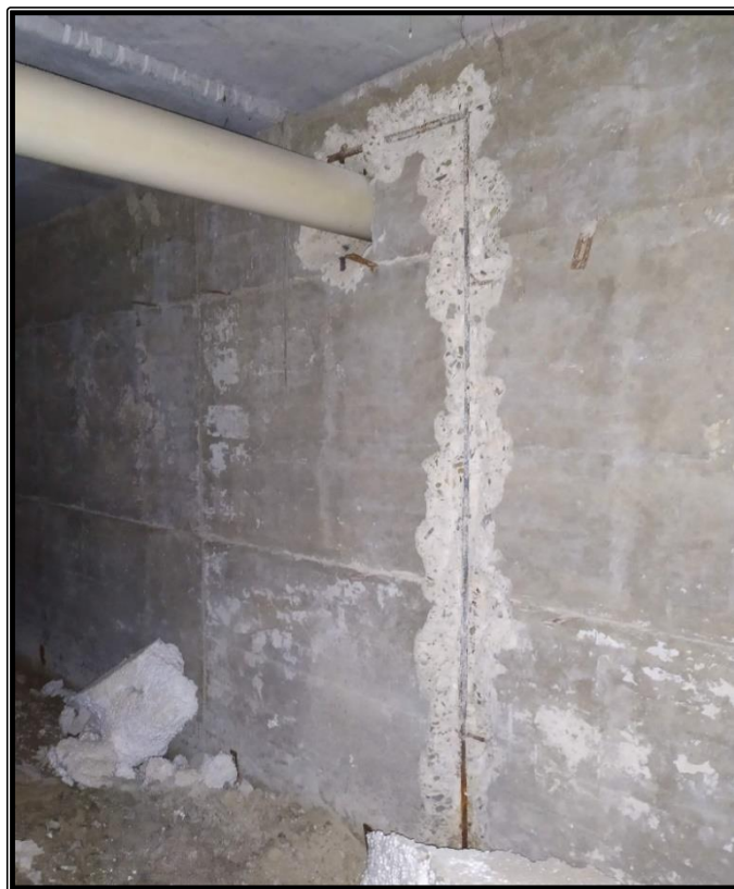
Figura 18 – saggio sui ferri di armatura della fondazione
